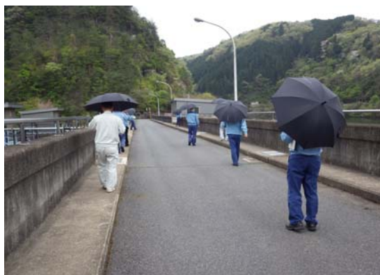
ダム堤頂道路点検状況
